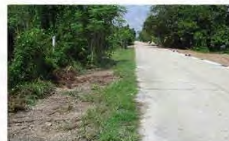
ก่อสร้างรางระบายน้ำ สายหนองตาโพธิ์ หมู่ที่ 1
