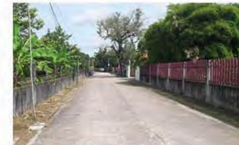
ก่อสร้างรางระบายน้ำ สายอวบพัฒนา หมู่ที่ 6
