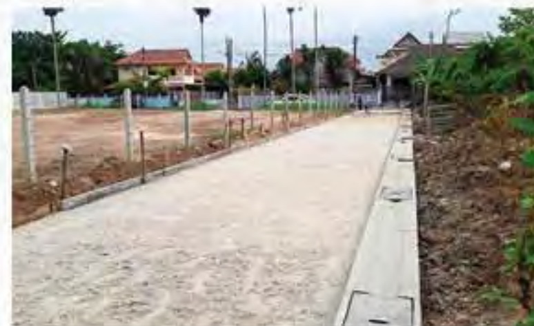
ก่อสร้างถนน ค.ส.ล. พร้อมราง ระบายน้ำ สายเมจิก 3 หมู่ที่ 6
