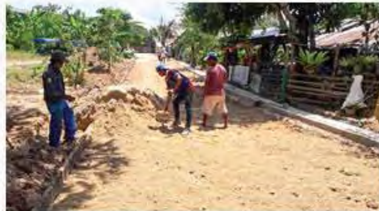
ก่อสร้างถนน ค.ส.ล. พร้อมรางระบายน้ำ ซอยเขตประดู่ 4 หมู่ที่ 6
